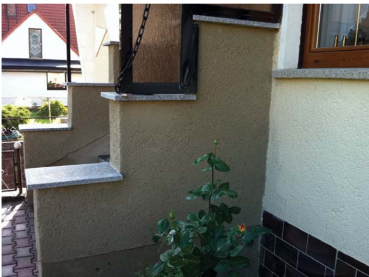
Treppenaufgang verputzt mit Genial Feuchteregulierungsputz passend zum Kratzputz des Hauses.
