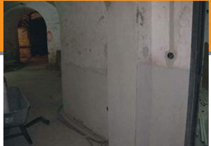
Gewölbe-Teilflächen nach der Sanierung unten Feuchteregulierungsputz und oben Altputz.
