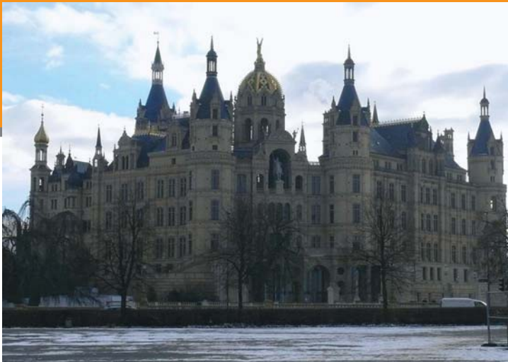
Im Schweriner Schloß wurden 2012 notwendige Sanierungsarbeiten durchgeführt.
