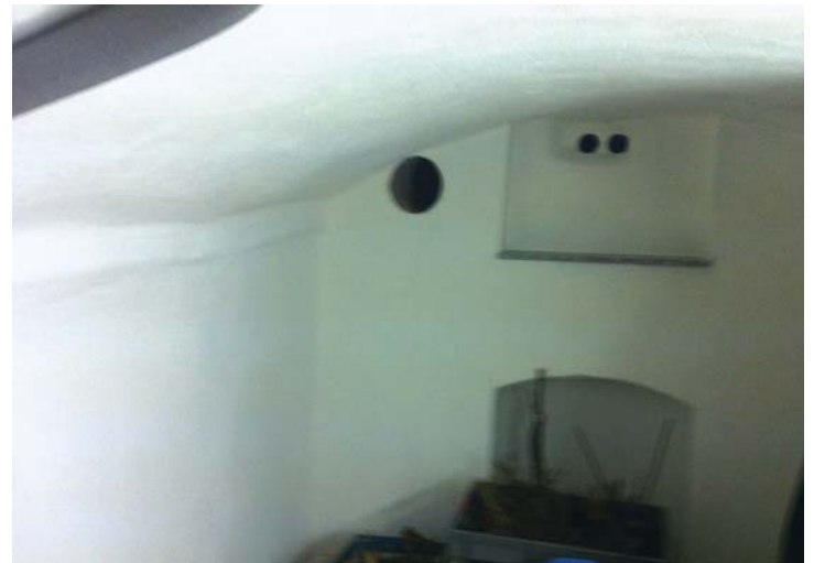
Nach dem Verputzen wurde der Gewölbekeller noch mit der KALKOpor Kalkfarbe gestrichen.
